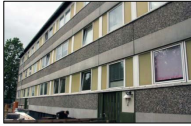
Traneparken før renoveringen.
